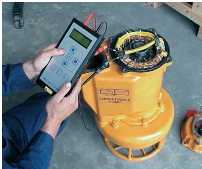
Контроль состояния электрического двигателя и насоса позволяет принимать правильное решение об их ремонте или замене.
